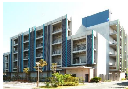
横浜新技術創造館外観
