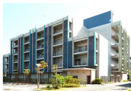
横浜新技術創造館外観
