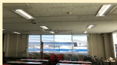
蛍光灯からLED照明に入れ替えた本社屋内
