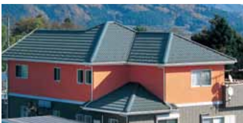
地震に強くさびにくいガルバリウム鋼板屋根
