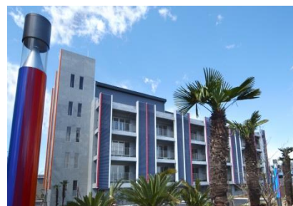
横浜新技術創造館外観
