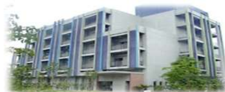
横浜新技術創造館外観
