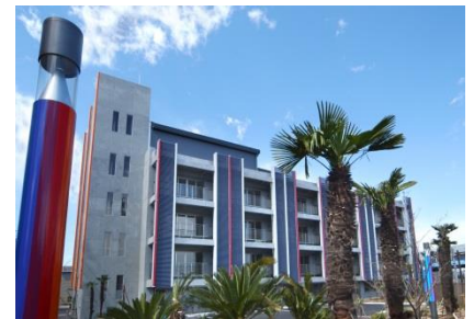
横浜新技術創造館外観
