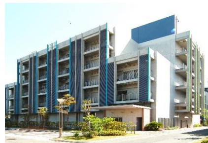
横浜新技術創造館外観
